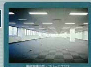
事務室棟内部・フリーアクセス
